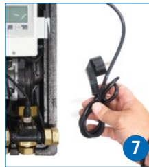
Schließen Sie die Station an den Strom an.
