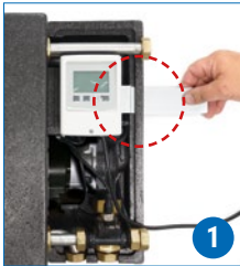
Befestigungsschiene von RECHTS her montieren.
