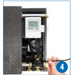
Führen Sie das Netzkabel aus einem der beiden seitlichen Eingänge heraus.
