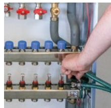
7. Wasserzulauf beenden. Füll- und Entleerhähne schließen. Schläuche abnehmen und die Kappen montieren.
